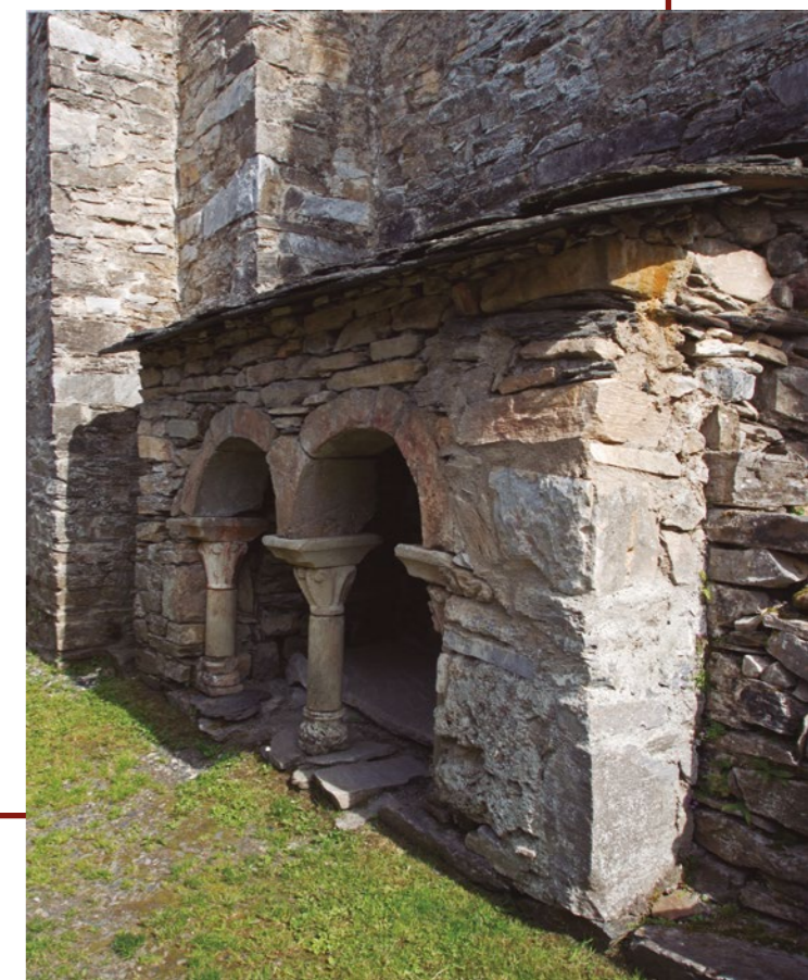
Exterior Iglesia Santiago de Peñalba
