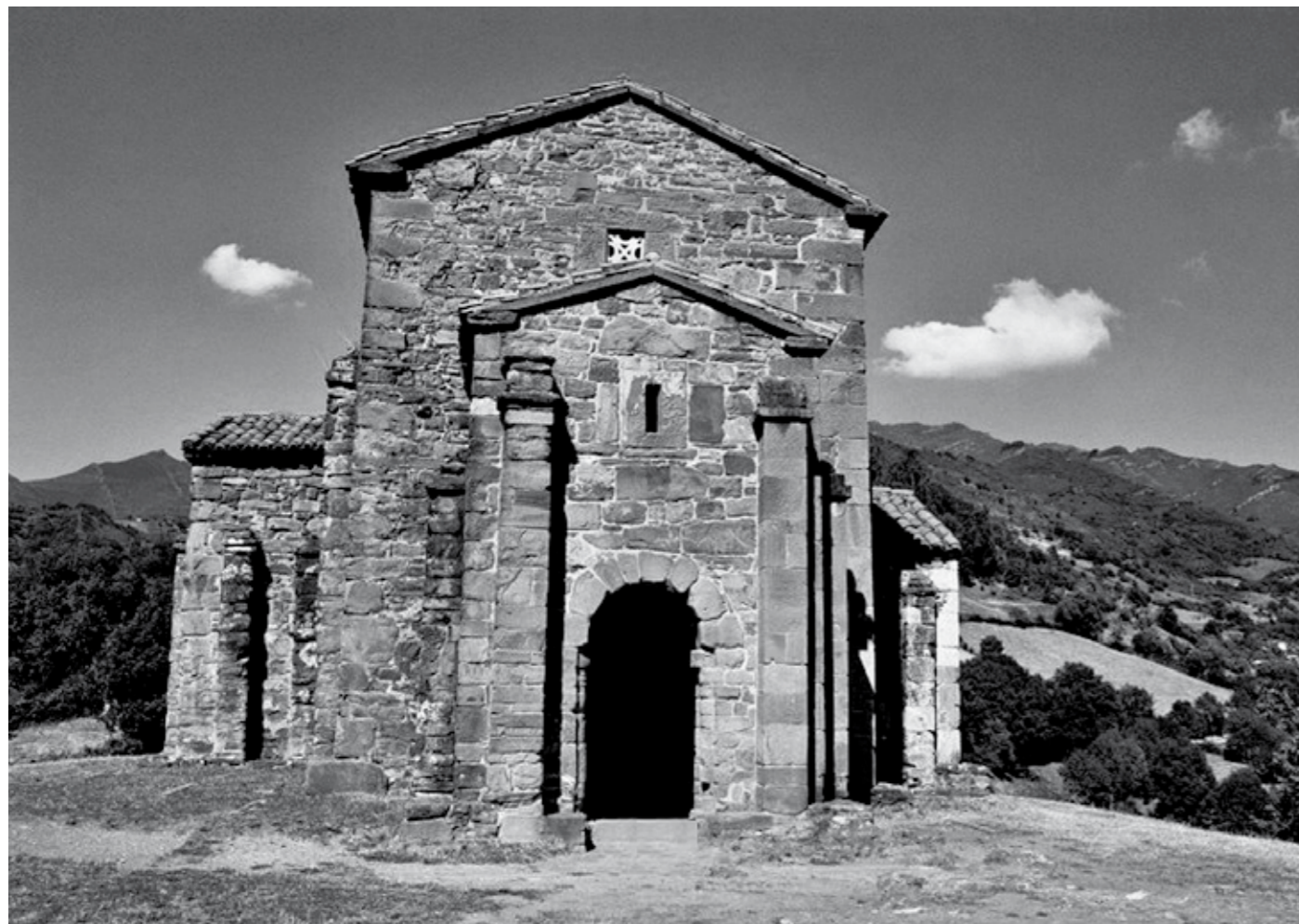
Fachada oeste de Santa Cristina de Lena, observar el conjunto de contrafuertes
