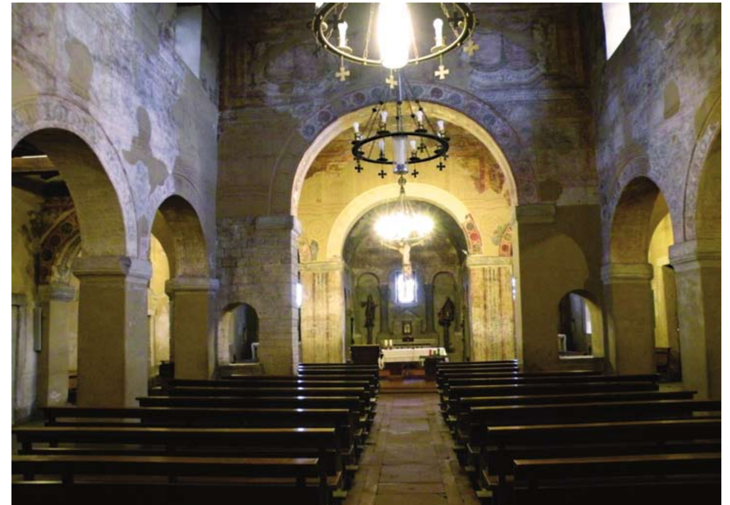
Interior de San Julián de los Prados. Planta basilical, de tres naves, separadas por arquerías de medio punto sobre pilares cuadrados.
